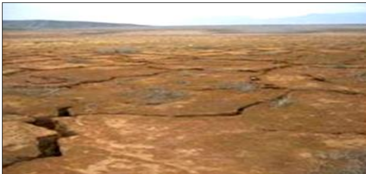
Рисунок 5.4. – Трещины-такыри на поверхности Дигмайского хвостохранилище
