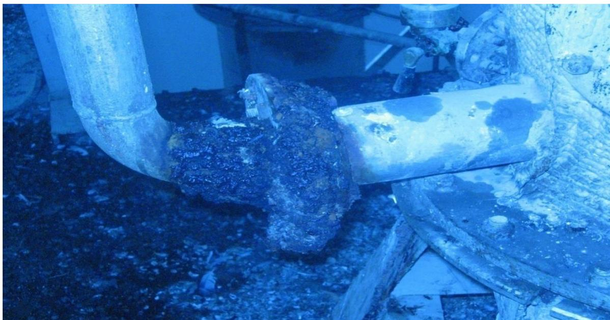
Рис.3.24. Пароприёмник ректификационной колонны.
